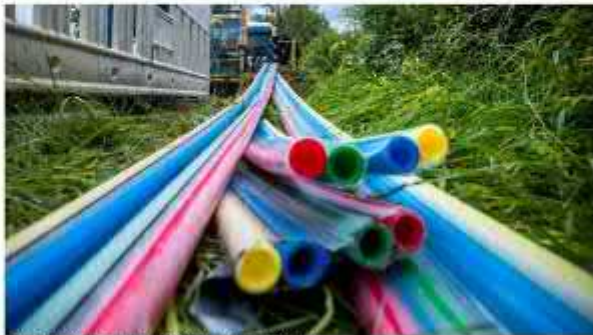
Leerrohre für das spätere Verlegen von Glasfaserkabeln
