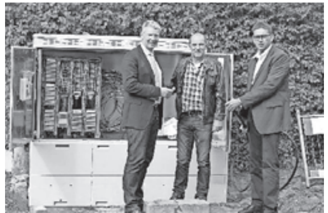
Der Breitband-Ausbau in Gottenheim ist auf dem Weg: Bürgermeister Christian Riesterer, Bauleiter Ulrich Hügler und Telekom-Teamleiter für technische Infrastruktur, Wolfgang Hägle, beim Vor-Ort-Termin in der Hauptstraße.
