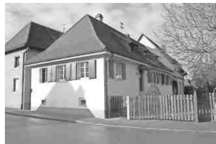
Durch den Kauf des Hauses in der Hauptstraße 40 in Gottenheim hat die Gemeinde weitere Unterkünfte, in denen der Gemeinde zugewiesene Flüchtlinge untergebracht werden können.
