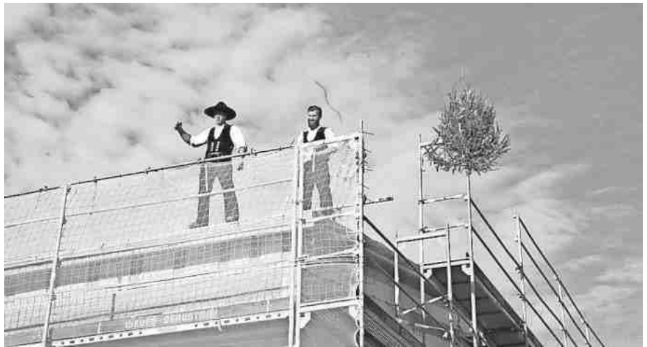
Zimmerermeister Mike Geiger sprach am Freitag den Richtspruch für den Kindergarten.
