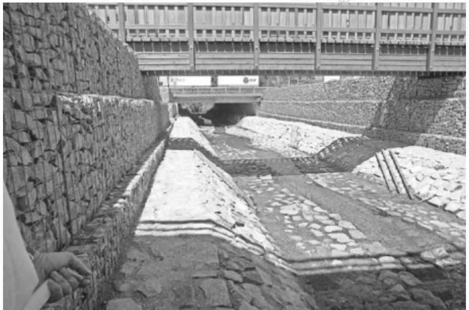
Unter der A 5 fließt der derzeit wasserarme Mühlbach Richtung Umkirch
