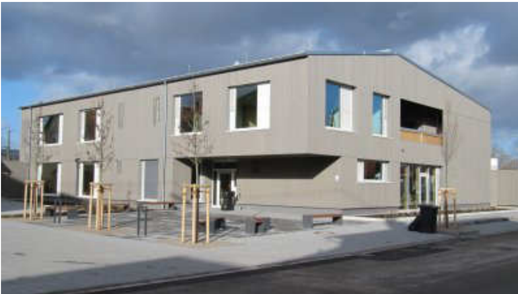
Abbildung 10: Fertiggestellter Neubau der Kita, https://www.gottenheim.de/Kindergarten/
