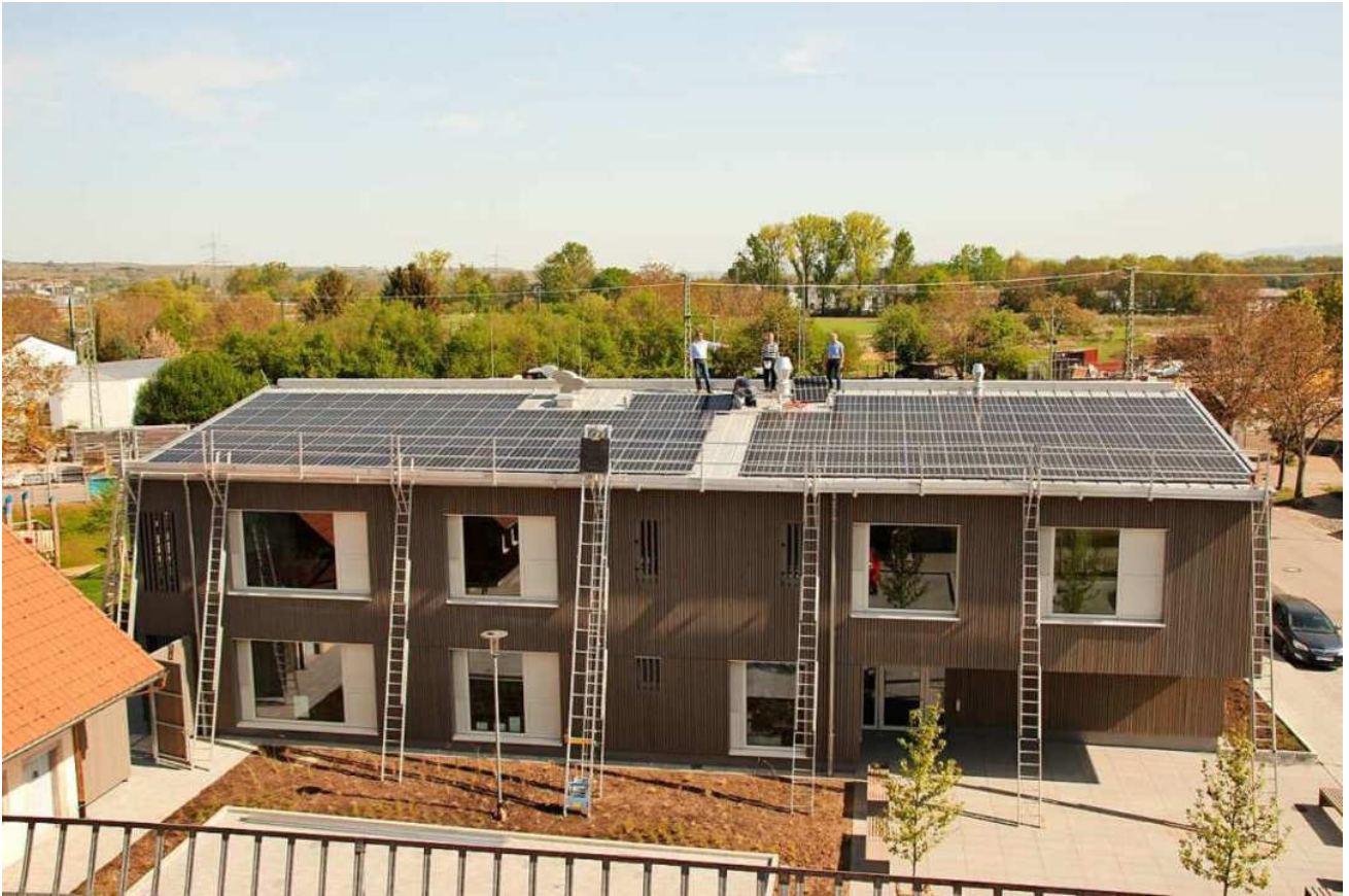
Abbildung 17: Bau eines Solardachs auf dem neuen Kita-Gebäude (Foto: Mario Schöneberg, BZ)
