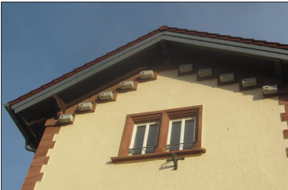
Abb. 8: Bahnhofsgebäude mit Nistkästen für Mauersegler.
