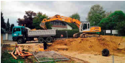
Aushub einer Baugrube
