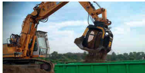
Sieblöffel im Einsatz
