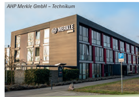
AHP Merkle GmbH – Technikum
