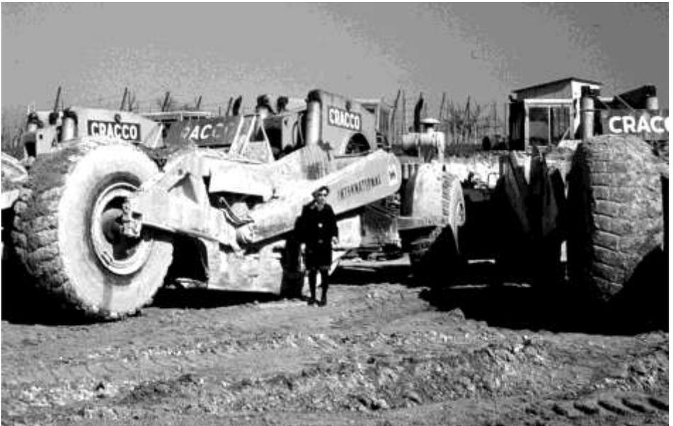
Während der Flurbereinigung: Große Baumaschinen zum „Abhobeln“ und Planieren der neuen Flächen
