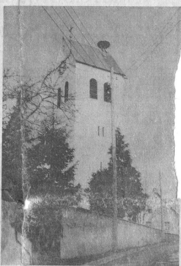
Auf seiner Anhöhe blickt der Kirchturm der St.-Stephanskirche über Gottenheim hinweg zum Kaiserstuhl hinüber. Sehen im Dreißigjährigen Krieg wurde, das Glockenhaus zerstört. Im Zweiten Weltkrieg fiel der Turm dem Bomben-
