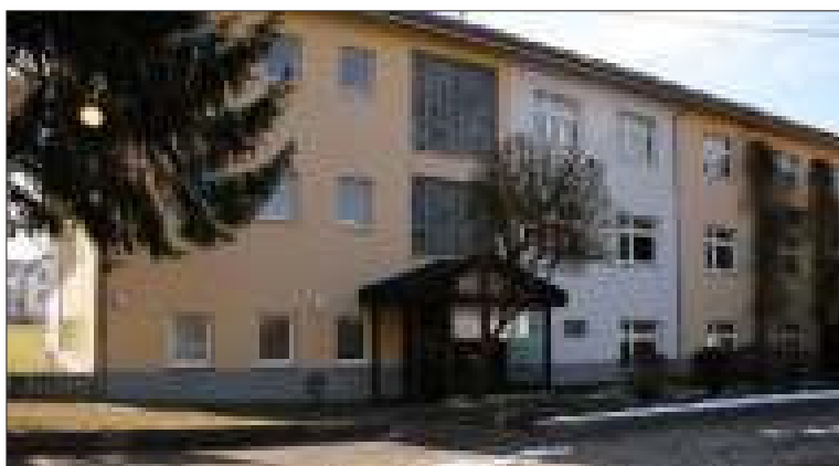
Im Gottenheimer Schulhaus soll eine Kleinkinderbetreuung eingerichtet werden. Die Gruppe wird über den Eingang zur Turnhalle erreichbar sein. Foto: ma
