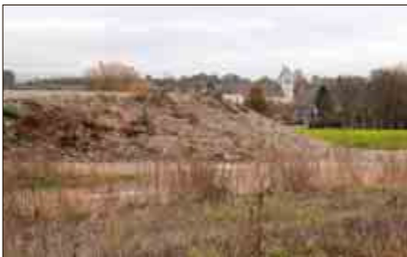
Über den Weiterbau der B-31-West von Gottenheim nach Breisach (hier im Bild die ersten Aufschüttungen bei Gottenheim für den Anschluss Bötzingen) gibt es unterschiedliche Positionen. Der VLO ist dagegen. Foto: ma
