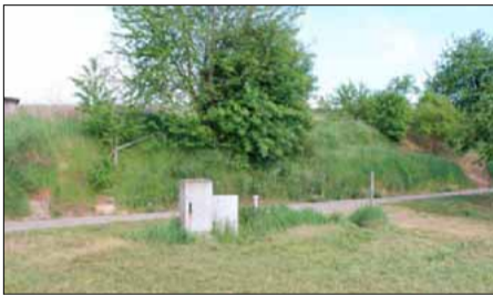
Die zurzeit stillgelegte Wasserentnahmestelle
