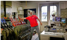
Hebelbrüfte mit Seilzugsmechanik: Fahrdienstleiter Klaus Melcher legt das Signal um. FOTO: UTE SCHÖLER
