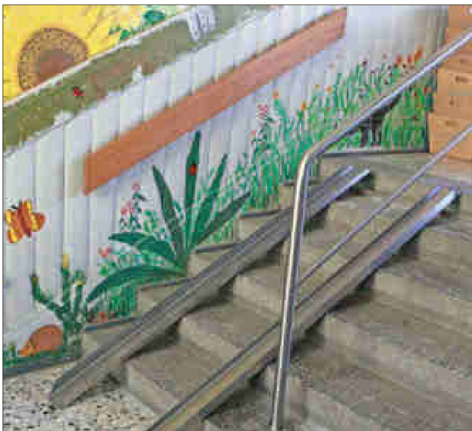
Barrierefreiheit im Schulhaus ist nun dank einer Rampe gewährt. Foto: ma
