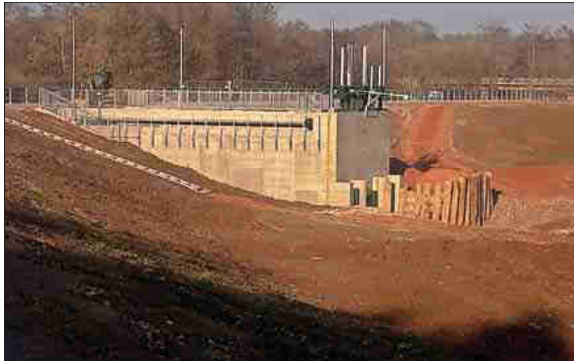
Mächtig wirkt der hohe Damm mit dem neuen Auslassbauwerk direkt an der A5. Das Regenrückhaltebecken Dietenbach, so Bürgermeister Walter Laub, soll noch in diesem Jahr fertig werden.
