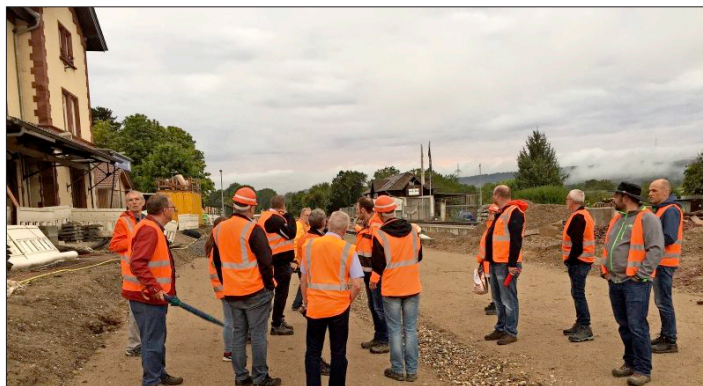
Der Gottenheimer Gemeinderat informierte sich am Bahnhof über den Fortgang der Bauarbeiten.
