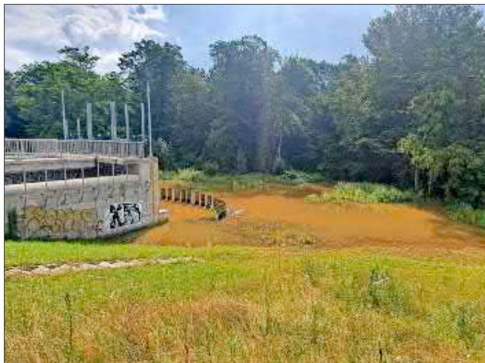
Auf gut zwei Meter angestaut war das Regenwasser im Dietenbachbecken an der A5 zwischen Umkirch und Freiburg.
