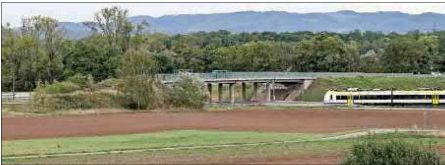
Die B 31 West endet in Gottenheim mit dem Brückenbauwerk, das über die Strecke der Breisgau S-Bahn führt, bislang aber ungenutzt ist. Foto: dbe
