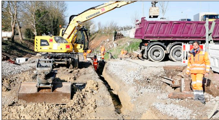
Jörg Krings (rechts) leitet die Baustelle an der Bötzingen Straße. Foto: ma
