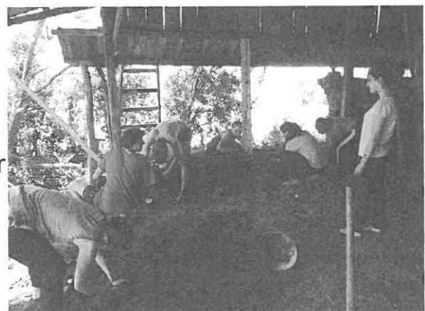
traditioneller Mauerbau einer Casita
