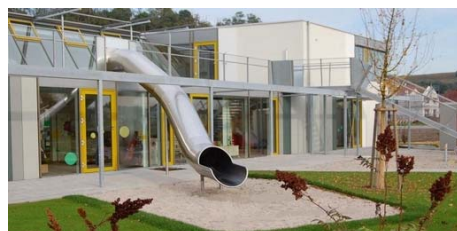
Rutsche Zugang vom OG zum Außenbereich
