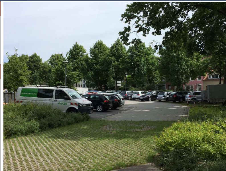
Bild: Parkplatz mit Rasengittersteinen (© E. Hipler, GEO-NET)
