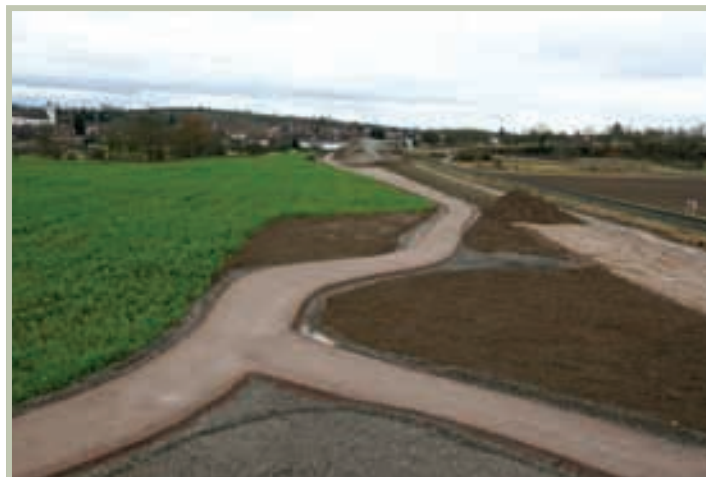
Die Straße ist im Bau – die Spuren in der Landschaft zeigen es. Der Weiterbau der B-31-West bis Breisach wurde aber jetzt gestoppt.
