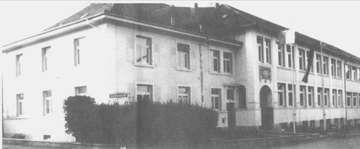
Grund- und Hauptschule der Gemeinde.
