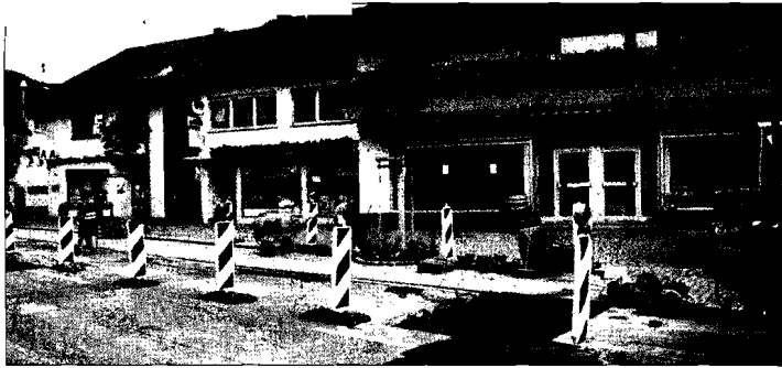
Die Baustellen im Dorf bringen Behinderungen für die Anwohner mit sich.
