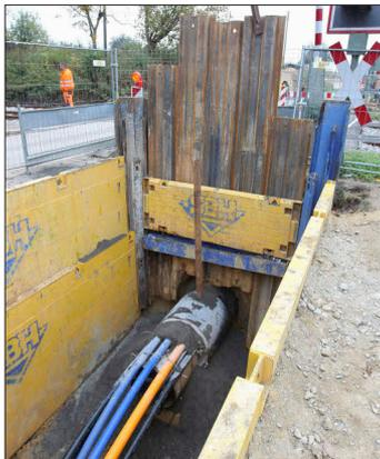
Ein Stahlrohr muss unter der Bahnlinie durchgetrieben werden.
