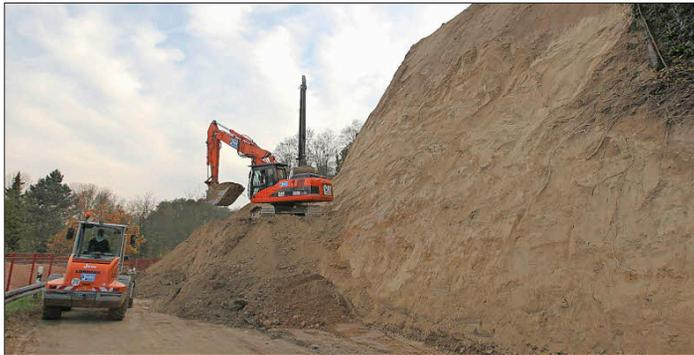
**Alles, was lose ist, muss weg:** Derzeit wird der Hang Richtung Waltershofen, der im April abgerutscht ist, abgeräumt. Anschließend finden Pflegearbeiten an der Böschung statt.
