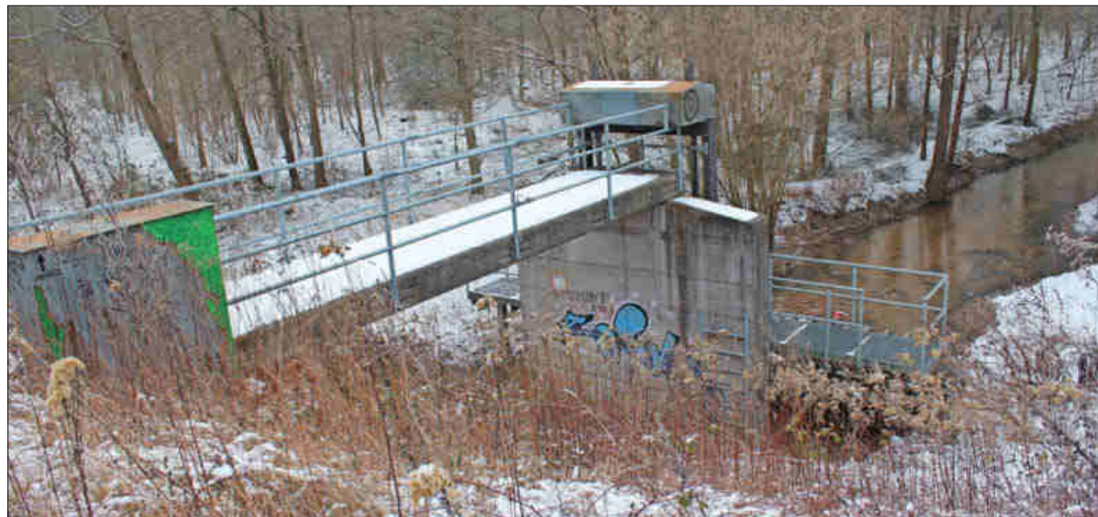
Das Hochwasserrückhaltebeckens Dietenbach bei Freiburg, gelegen zwischen Mundenhof und Autobahnkreuz Freiburg Mitte, soll durch den Entwässerungsverband Moos saniert und ausgebaut werden. Foto: mag
