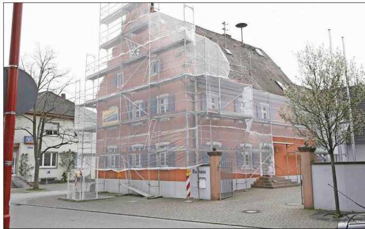
Das Rathaus in Gottenheim hat einen neuen Anstrich bekommen. Foto: ma
