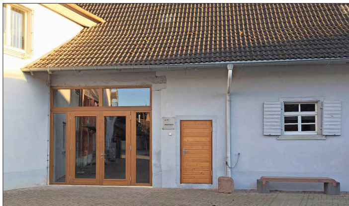
Der neue Eingangsbereich in die Rathausscheune wertet die Bürgerscheune auf und ist auch energetisch sinnvoll.
