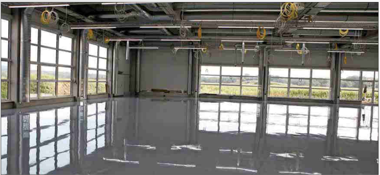
Modernste Technik und ein freier Blick nach draußen: Die Mitarbeiter von SensoPart freuen sich auf den Umzug in die neue Produktionshalle.
