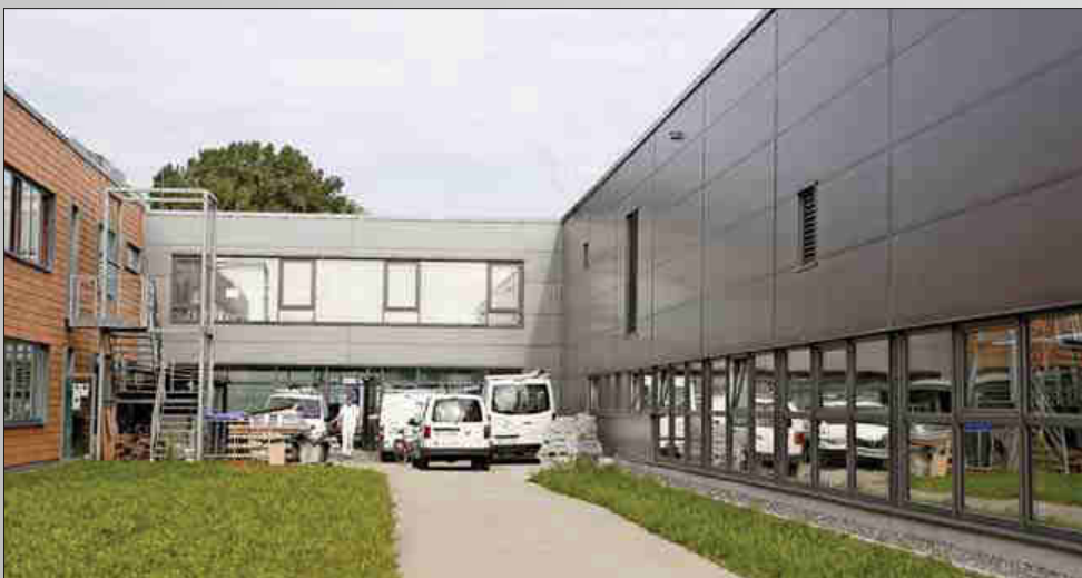
Die Verbindung zwischen dem bestehenden Gebäude und der neuen Produktionshalle ist bestens gelungen. Im Zwischenbau wird eine Mensa untergebracht. Fotos: ma
