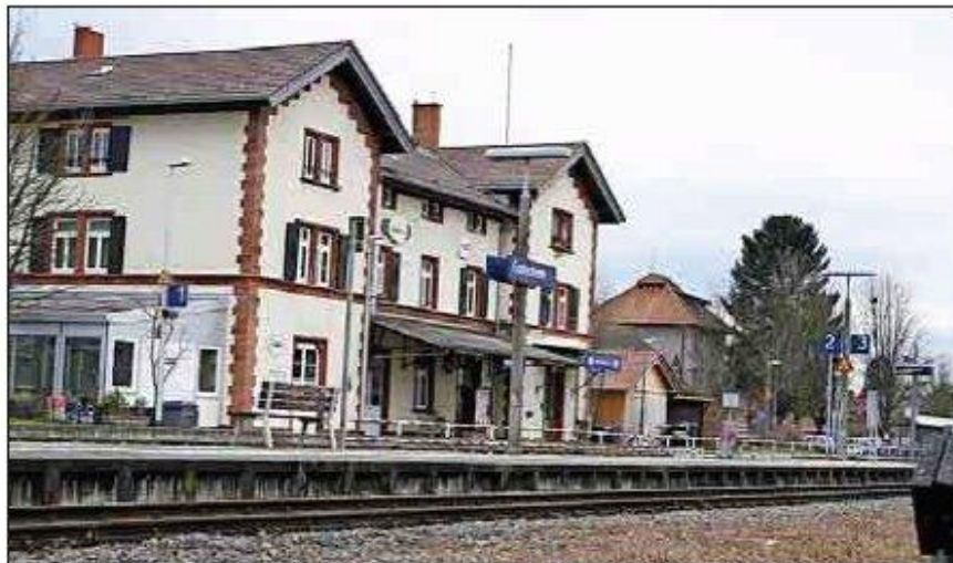
Der Gottenheimer Bahnhof wird im Zuge der Elektrifizierung der Breisgau-S-Bahn umgebaut. Der Bahnübergang zum Hinterfalter wird dabei geschlossen.
