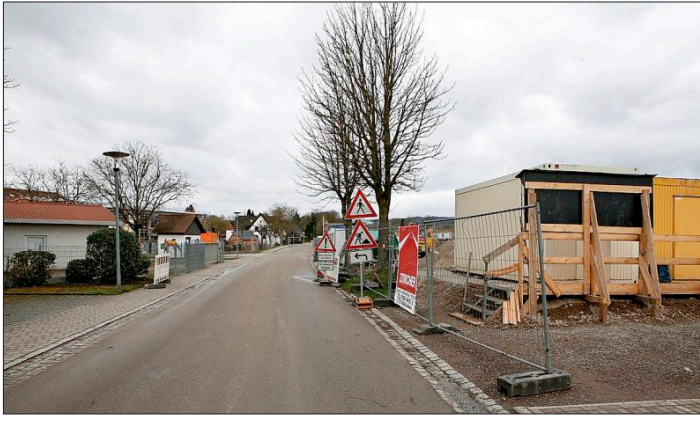
Die Bahnhofstraße und die Schulstraße in Gottenheim verändern ihr Gesicht. Zunächst steht aber der Umbau des Bahnhofs auf dem Programm. Foto: ma
