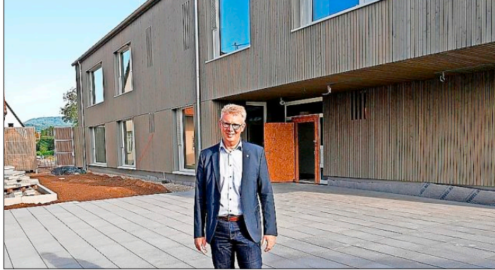
Bürgermeister Christian Riesterer vor dem neuen Kindergarten in der Schulstraße, der Ende Oktober fertig sein wird. Foto: ma
