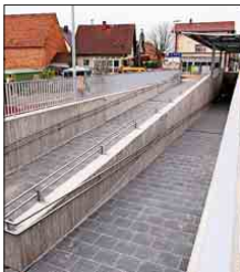
Barrierefrei: Die Rampe und der Fahrstuhl am Gottenheimer Bahnhof wurden jetzt fertiggestellt. Foto: ma
