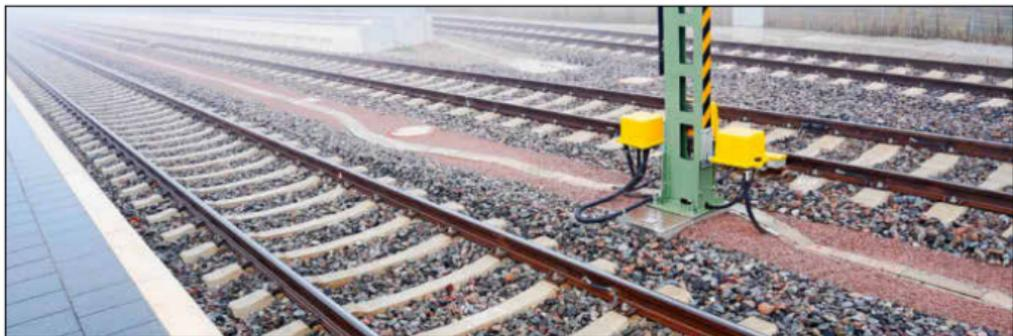
Gegen den Schienenlärm auf der Breisacher Bahn sollen ortsfeste Schienenkopfkonditionierungsanlagen an den betroffenen Gleisabschnitten – vor allem in Kurven – installiert und die Gleise mit einem speziellen, geräuschmindernden Mittel besprüht werden.
