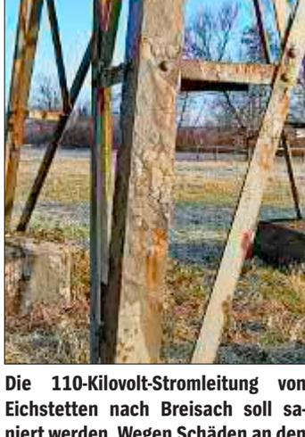
**Die 110-Kilovolt-Stromleitung von Eichstetten nach Breisach soll saniert werden. Wegen Schäden an den Stahlträgern ist die Sicherheit der Masten nicht mehr gegeben.** Foto: dhe
