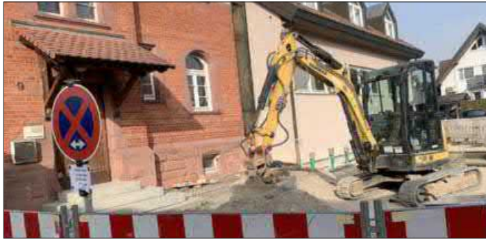
Die Bauarbeiten für die Modernisierung und Erweiterung des Gottenheimer Feuerwehrhauses haben begonnen.
